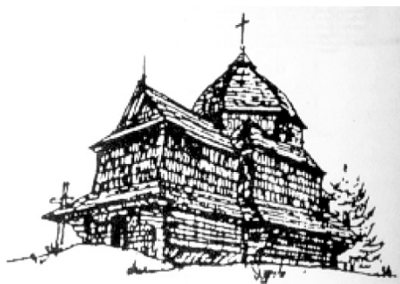
Domniemana cerkiew w Sitnie, wybudowana kosztem rządu rosyjskiego w 1871 lub w 1875 r. albo gruntownie przebudowana z już istniejącej starej świątyni, wg rysunku zamieszczonego w pracy: W. Słobodian, „Drewniane budownictwo Chełmszczyzny i Południowego Podlasia w greko-katolickim okresie”, „Lubelszczyzna”, numer specjalny, wrzesień 1996, s. 60
