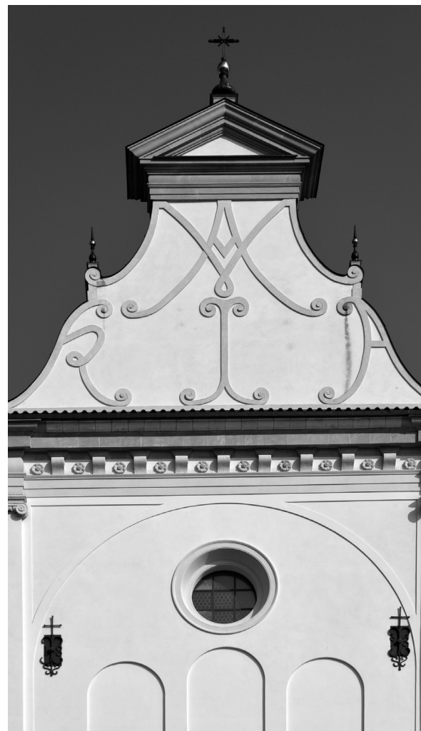
Elewacja zachodnia Katedry Zamojskiej. Fot. Ł. Kot
