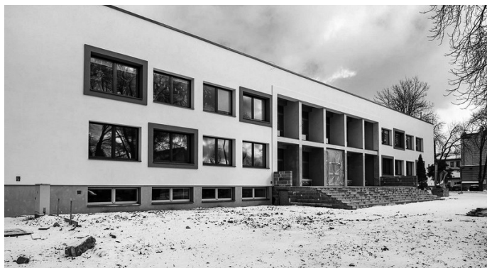
Zamojski Dom Kultury w trakcie modernizacji. Fot. ZDK
